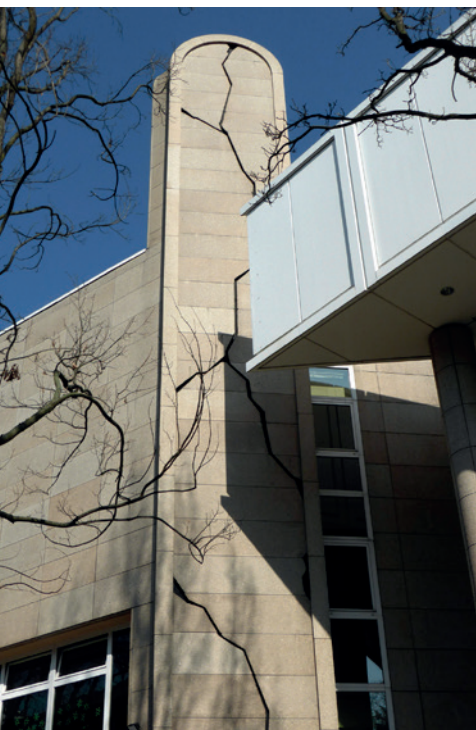
Das von Salomon Korn entworfene jüdische Gemeindezentrum in Frankfurt/M; Foto: HGVorndran
